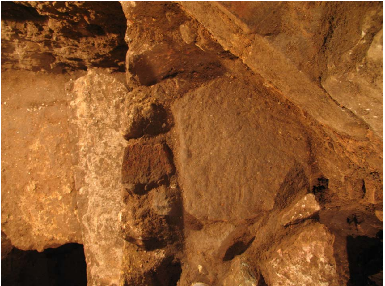
Vista parcial en planta del mur 22, on es pot veure la gran pedra esmentada. (042-11-145)
